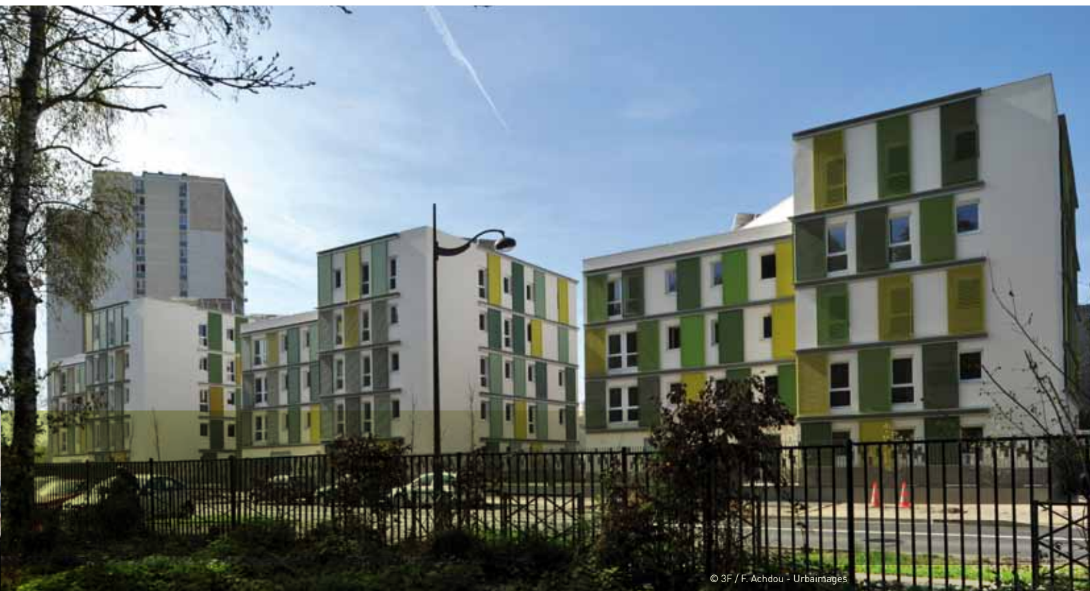
I3F, Clichy-sous-Bois (93) - Arch. : Atelier Tarabusi
